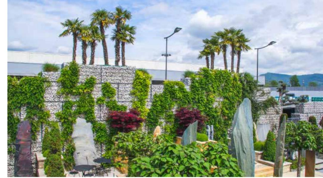
L'esempio mostra un muro di contenimento terra alto 2 metri realizzato al di sopra di una fondazione in ghiaia.
