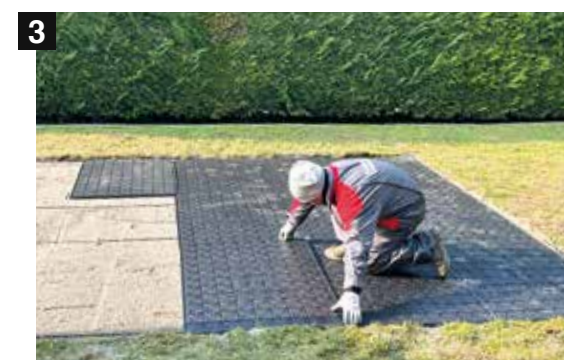
3 Posizionare FAST BASE e tagliarlo sul perimetro Position FAST BASE and cut it on the perimeter Positionieren Sie Fast Base und schneiden Sie die Enden zu. Positionner FAST BASE et découper-le sur le périmètre
